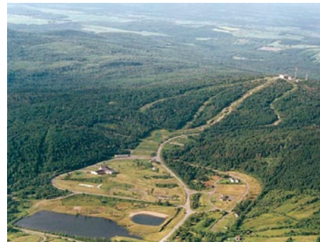
L'écovillage se bâtit sur une ancienne base militaire, sur une montagne atteignant 698 mètres d'altitude.
