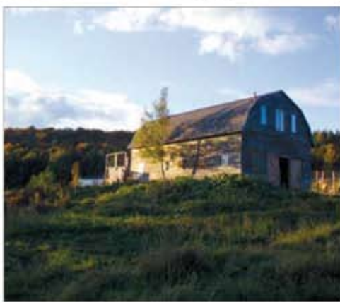
Une des infrastructures construites sur le domaine du Mont Sainte-Marguerite.
